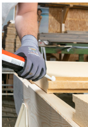
Stoßdetail/-abdichtung bei Dachelementen mit GUTEX Prefatop® (Detail 1.1.601)
