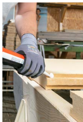
Stoßdetail/-abdichtung bei Dachelementen mit GUTEX Prefatop® (Detail 1.1.601)
