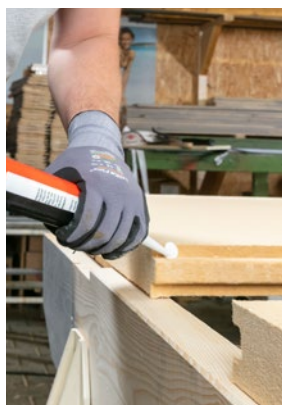
Stoßdetail/-abdichtung bei Dachelementen mit GUTEX Prefatop® (Detail 1.1.601)
