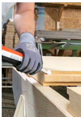
Stoßdetail/-abdichtung bei Dachelementen mit GUTEX Prefatop (Detail 1.1.601)
