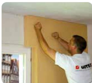
**Schritt 2:** GUTEX Thermoroom® vollflächig mit GUTEX Klebe- und Spachtelputz auf dem vorbereiteten Untergrund verklebt. Es sind **keine zusätzlichen mechanischen Befestigungen notwendig**.
