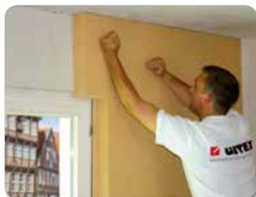
werden. Kreuzfugen sind nicht zulässig. Zusätzlich müssen die Dämmplatten mit dem Untergrund verdübelt werden. Es sind 6 Tellerdübel pro m<sup>2</sup>
