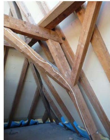
Abb 7. Nord-Ost Ansicht mit offenem Dach, Verlegung GUTEX Ultratherm Holzfaserdämmplatten (Quelle: GUTEX, Martin Granacher) Abb 8. Abdichtung des Steildaches mit GUTEX Ultratherm der wind- und regensicheren Unterdeckplatte und zusätzlich Unterdachbahn. (Quelle: GUTEX, Martin Granacher) Abb 9. Innenansicht auf Dachstuhl mit GUTEX Ultratherm (Quelle: GUTEX).
