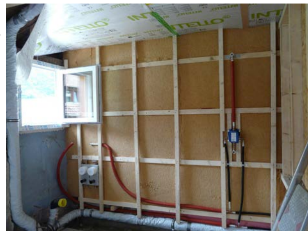
Abb 11+12. Dämmung der Außen- und Innenwände mit GUTEX Thermoflex in Holzständerkonstruktion. (Quelle: Bauherr/GUTEX)
