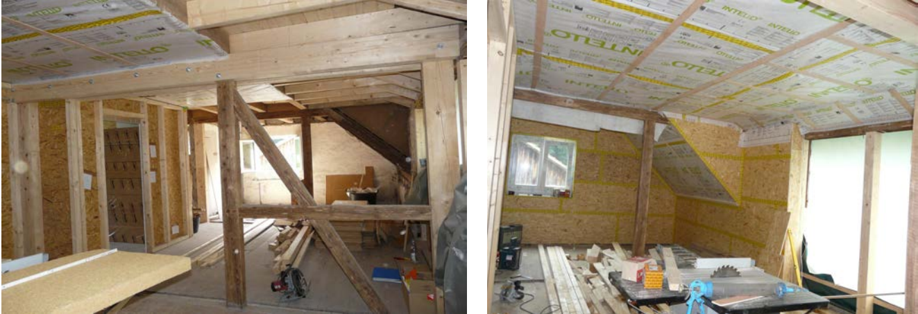
Abb 9. Großzügiger, moderner Wohn-Ess-Bereich, mit GUTEX Dämmung in Decke-, Wand- und Bodenaufbau (Quelle: GUTEX)
